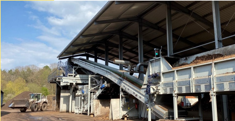
Abb. 4: 4-Fractionen-Schwingsiebzanlage mit FE-Metallabscheidung, Windsichtung und Steinfall zur gezielten Fremdstoffentfrachtung
