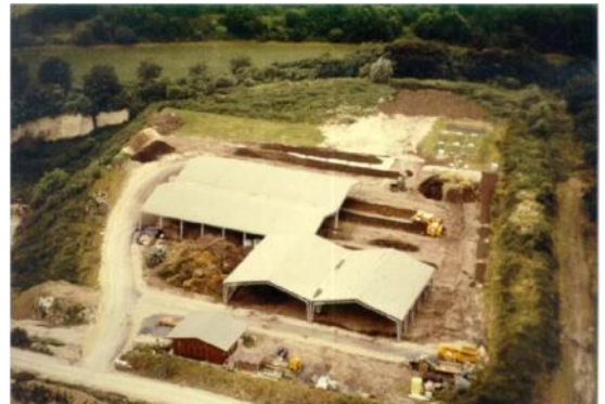
Die erste Kompostierungsanlage in Witzenhausen/Hessen
