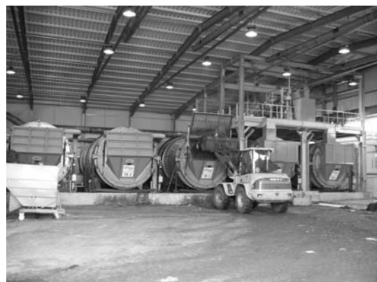
Befüllen der aus dem „alten“ Kompostwerk noch vorhandenen Rottetrommeln mit frischem Bioabfall zur Homogenisierung
