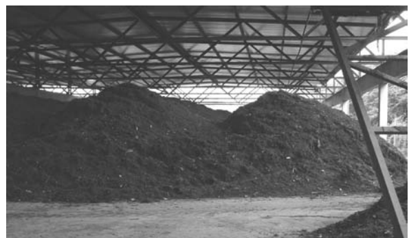
Nachrotte in der überdachten Halle
