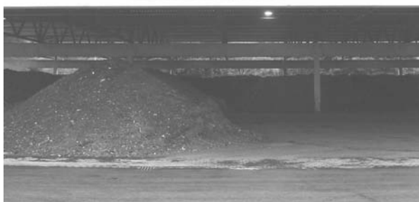
überdachte Nachrotte und Konfektionierung
