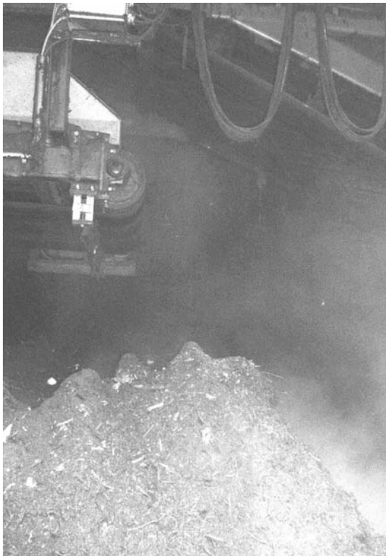
Eintrag in die Rottehalle durch Verteilerbänder
