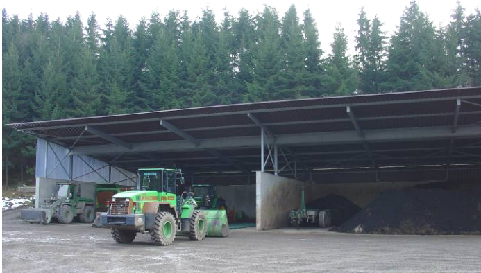
Maschinenhalle und Bodenlager
