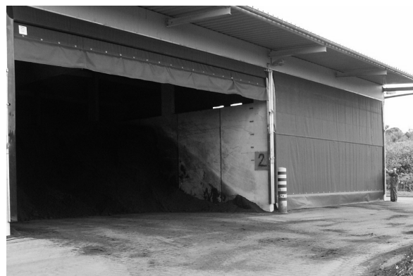
Fertigkompostlager mit Toren aus Netzen gegen Samenflug
