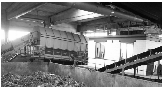
Aufbereitungshalle mit Siebtrommel zur Vorabsiebung
