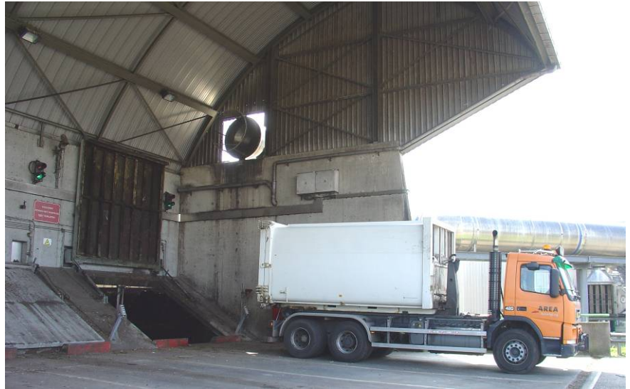
Abladen in die Annahmehalle
